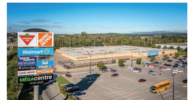
Walmart Canada Inc. Mega Centre Rive-Sud, Lévis, Québec
